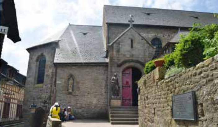
FARNÍ KOSTEL ST. PIERRE Farní kostel z 15. a 16. století je oficiálním místem věřících Archanděla svatého Michaela. Je zasvěcen svatému Petrovi, který dle katolíků drží klíče od nebeské brány. Poutníci vždy přicházeli na horu symbolicky před kostel sv. Petra, než se vydají do opatství, obraz ráje na zemi. Socha svatého Jana Křtitele, kterou najdete na vstupu do kostela vyzdává hold Archandělovi, který ho vedl během stoleté války. Místní hřbitov se nachází hned vedle farního kostela. Nachází se zde hrob Matky Poulardové.
